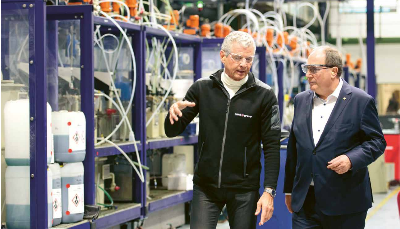
Hohe Rückgewinnungsquoten: Einblicke in den hydrometallurgischen Teil der Recycling-Anlage für Lithium-Ionen-Batterien bei der Primobius GmbH. Hier werden aus der „Black Mass“ die wertvollen Metalle wie Lithium, Nickel und Kobalt gewonnen. Das Ganze passiert nachhaltig und CO 2 -reduziert.
